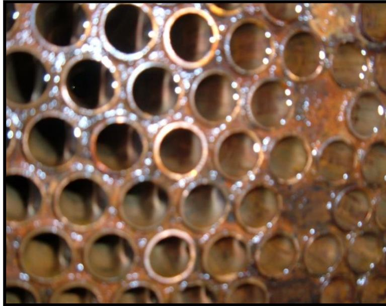
Figura 2 – Corrosão espelho de um trocador de calor
