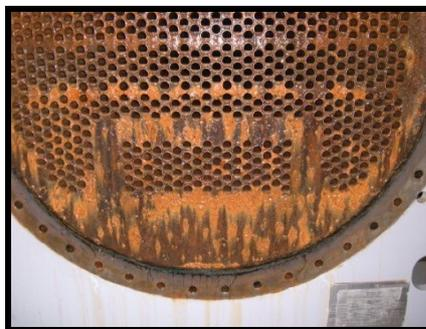
Figura 6 – Material orgânico no espelho de um condensador
